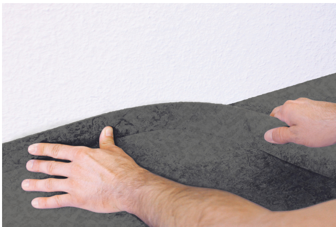
► Belagsstreifen zug und spannungsfrei ansetzen.
