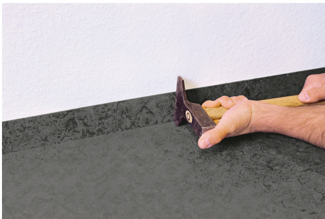
Belagsstreifen mit Druck vollständig anreiben.
